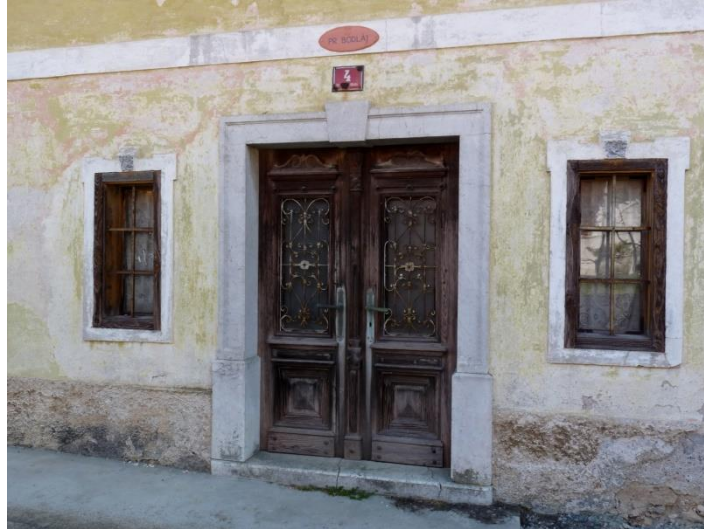
Vhod v staro Bodlajevo hišo, 2017 Vir: foto Miran Hladnik
